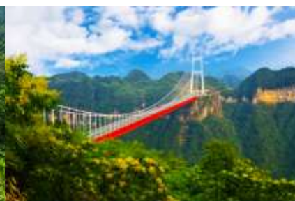
สะพาน ไอ้อ้ายถ้ำเจียว
